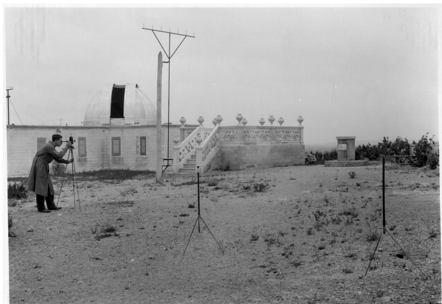
Figura 4: L'aparell que utilitza l'observador és un electròmetre de Wulf. S'utilitzava a l'Observatori de l'Ebre els anys vint i trenta per mesurar el potencial elèctric atmosfèric. En primer pla, i sobre petits tripodes, es veuen altres accessoris utilitzats per a la mesura. Darrere veiem la cúpula que protegia el telescopi i l'agulla nefoscòpica de Besson, utilitzada per estudiar la nebulositat (arxiu de l'Observatori de l'Ebre)
